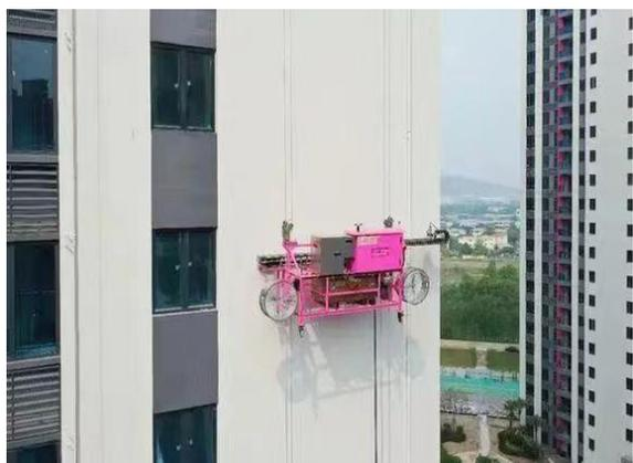
（卷扬式外墙乳胶漆喷涂机器人）
